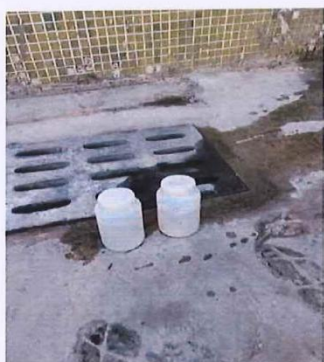
生活污水排放口
