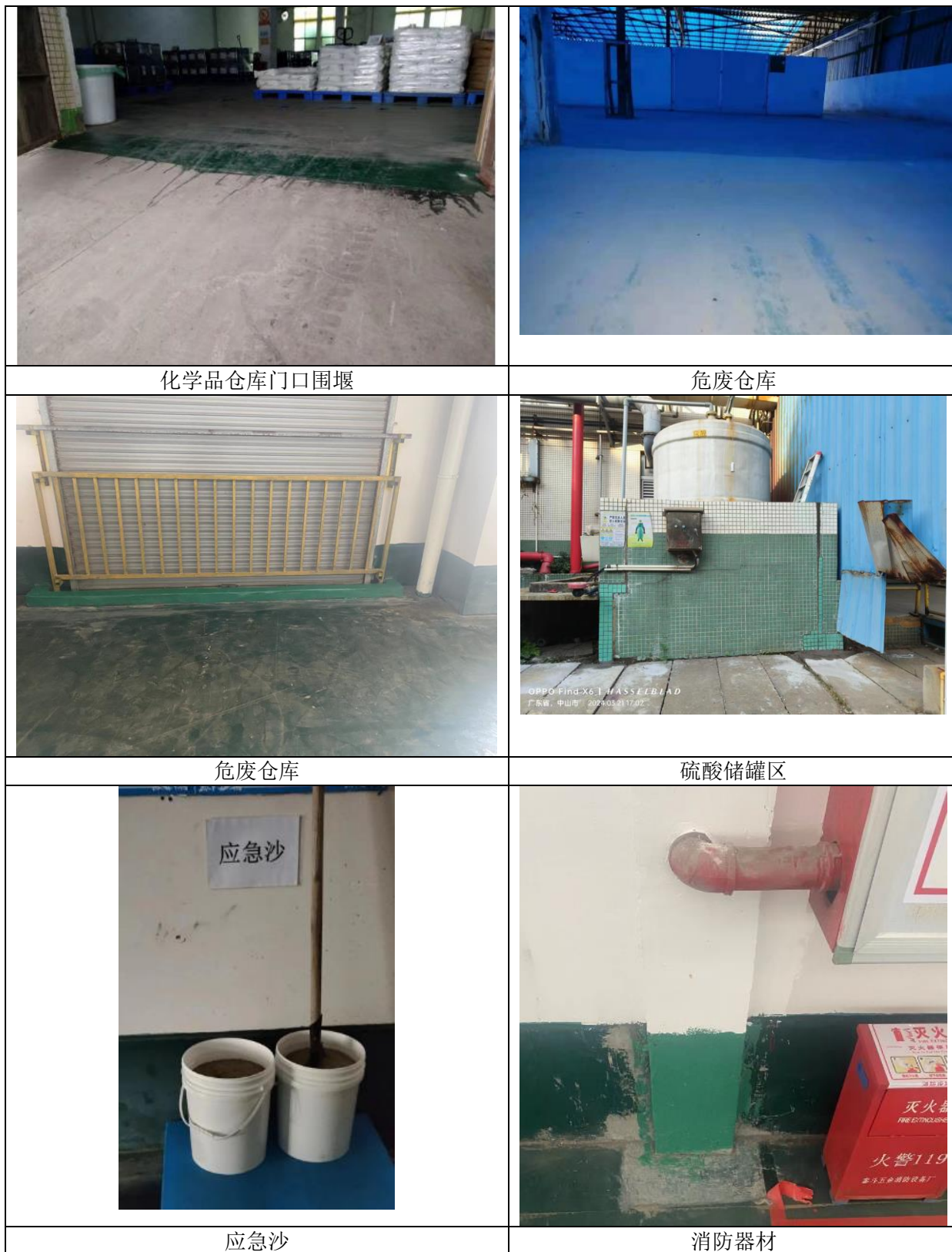
图2.1-1 风险防范设施照片
