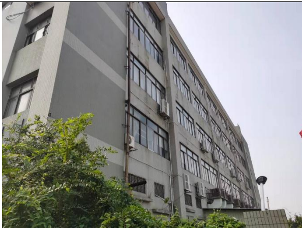
项目厂房 A 现状
