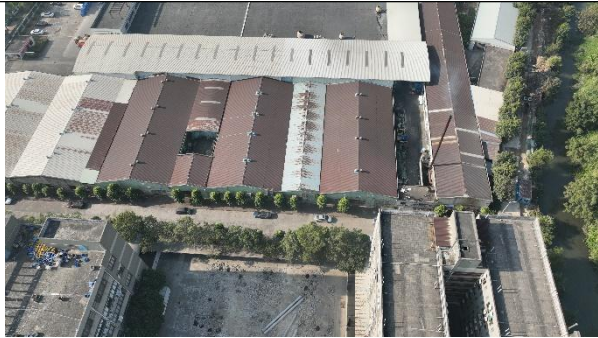
项目西南面现状（兆业南街，隔路为厂房群）
